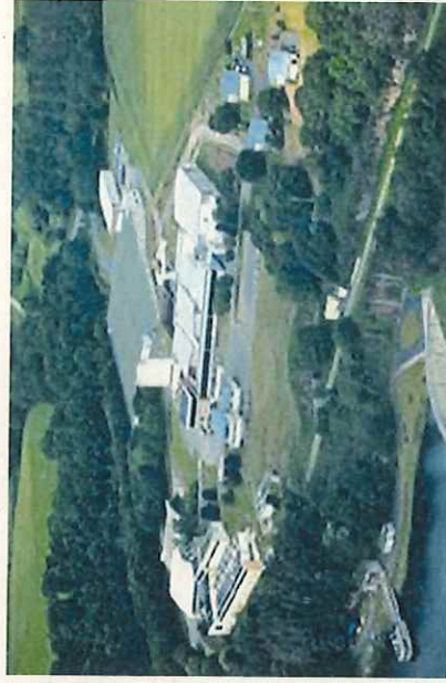
Usine de production d'eau potable https://www.smap22.fr
